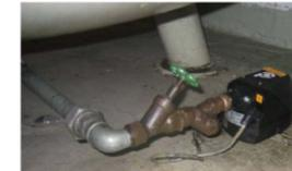
Am Druckluftbehälter ist ein niveaugesteuerter Ableiter vorhanden, welcher normalerweise für das bedarfsgesteuerte Entwässern des Behälters ohne unnötigen Druckverlust vorsieht. Wie auf dem Bild zu erkennen ist, befindet sich in der Kondensateintrittsleitung ein Sitzventil und ein Schmutzfängsieb. Dies kann zu Fehlfunktionen aufgrund von Luftschlüssen und Wassertaschen im Zulauf führen. Siehe hierzu Zitat aus der Bedienungsanleitung des Herstellers:
